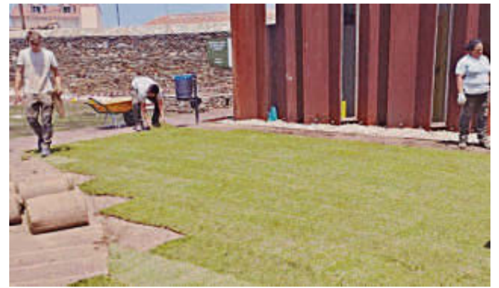
La instalación del sistema de tepes de césped. EÑE
