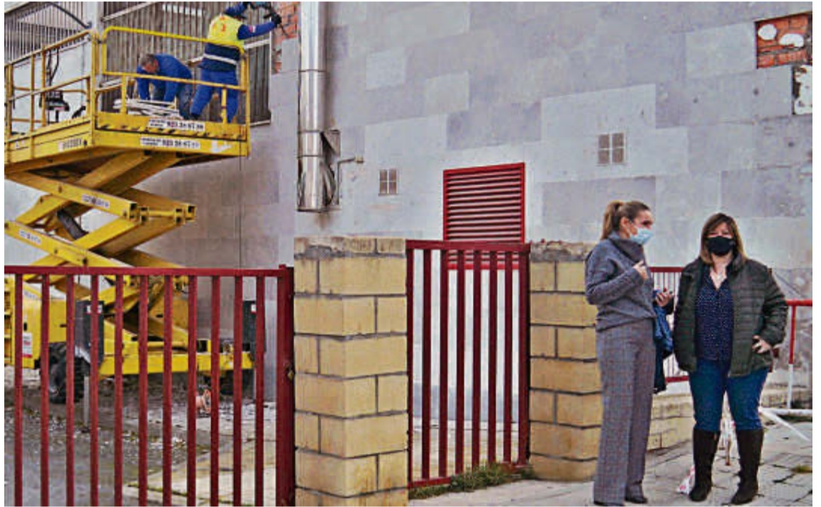
Las ediles Marta Labrador y Esther Casado junto a los operarios que han iniciado la obra de la Escuela Infantil. | EÑE
