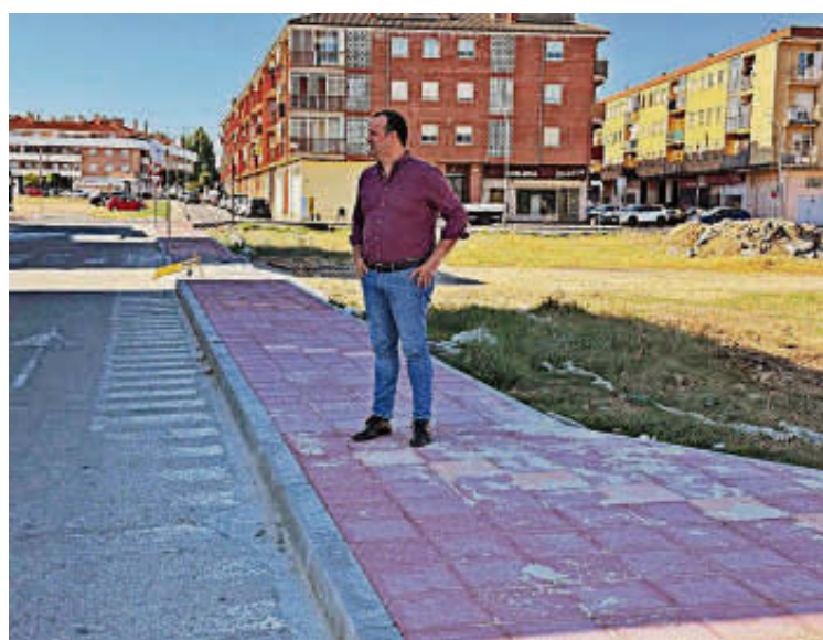
El alcalde, David Mingo, en las obras de la calle Juan XXIII. EÑE
