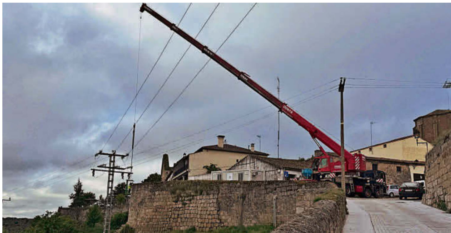
La maquinaria pesada con los operarios reconociendo los tramos de muralla de Ledesma derrumbada, en el inicio de la reconstrucción. EÑE
