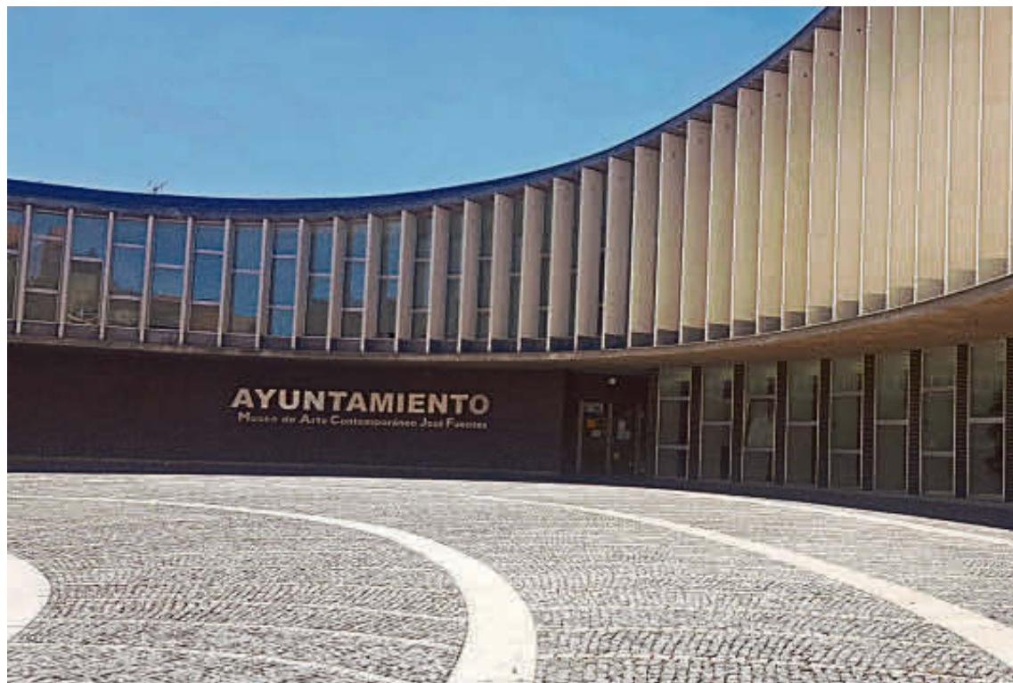
La Casa Consistorial de Santa Marta es el edificio más grande en el que se mejorará la eficiencia energética. | EÑE
