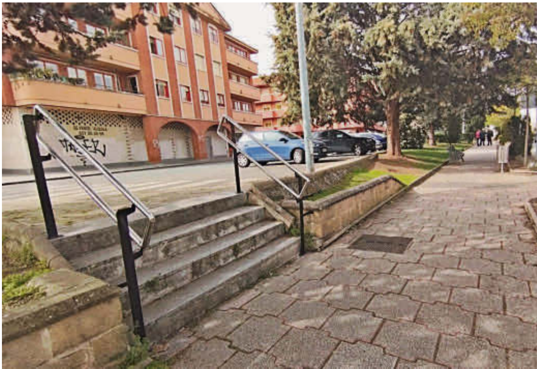
Nueva barandilla instalada en el entorno de Signo XXV en Santa Marta de Tormes. EÑE
