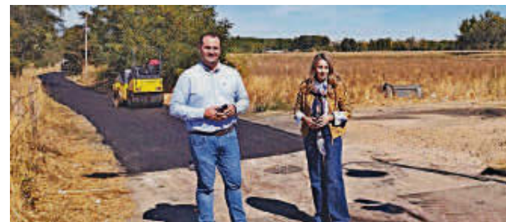
David Mingo y Marta Labrador en el lugar de las obras. EÑE
