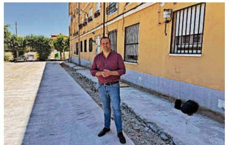
El alcalde, David Mingo, en las obras de acerado de la calle Cañamares. EÑE
