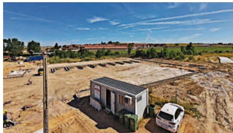
Las obras del Punto Limpio de Villamayor de Armuña. EÑE
