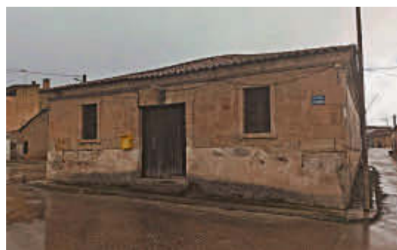
Antigua Casa Consistorial de Carbajosa de Armuña. EÑE
