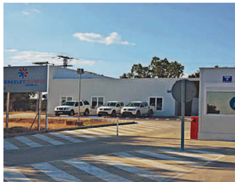
Acceso principal a las instalaciones de Berkeley en Retortillo. | CASAMAR
