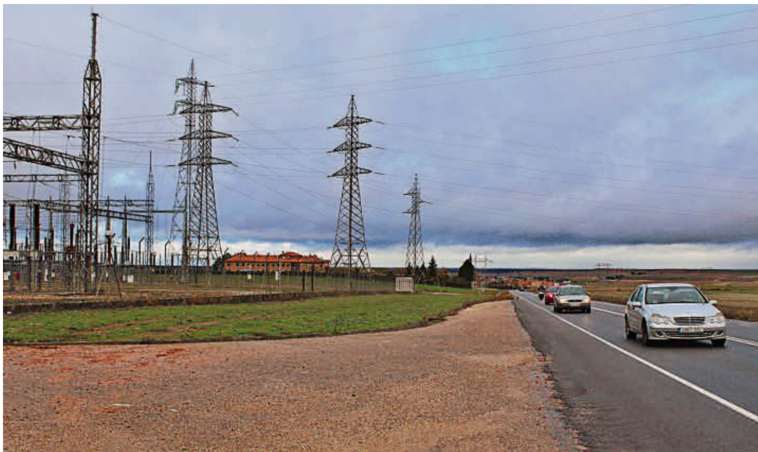
El punto del que arrancará la nueva ronda de Villamayor de Armuña, entre la subestación eléctrica y la residencia en la SA-300. EÑE
