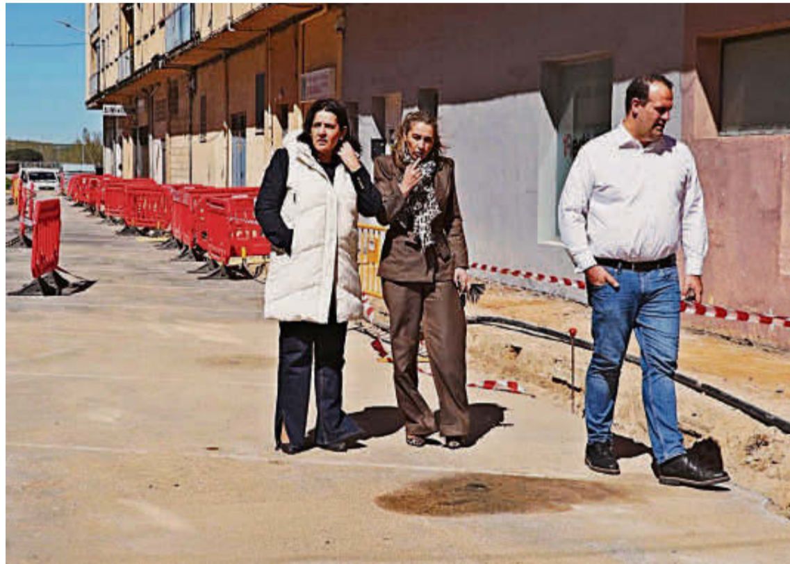
Silvia González, Marta Labrador y David Mingo en la visita a las obras del barrio del Carmen. EÑE
