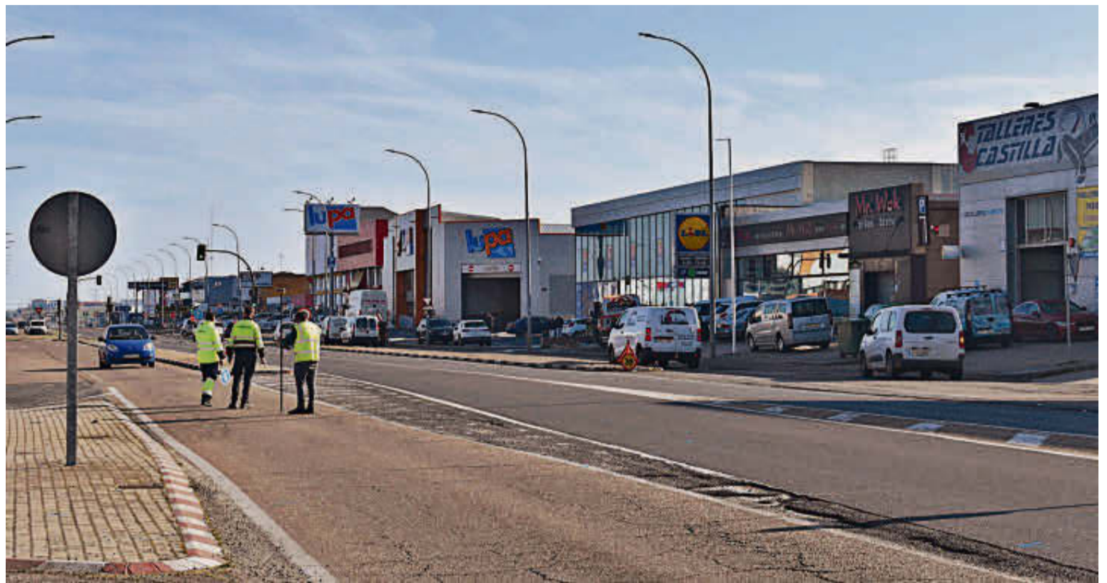
Primeros trabajos de señalización en la travesía del polígono industrial de Los Villares para comenzar la obra de la rotonda. EÑE
