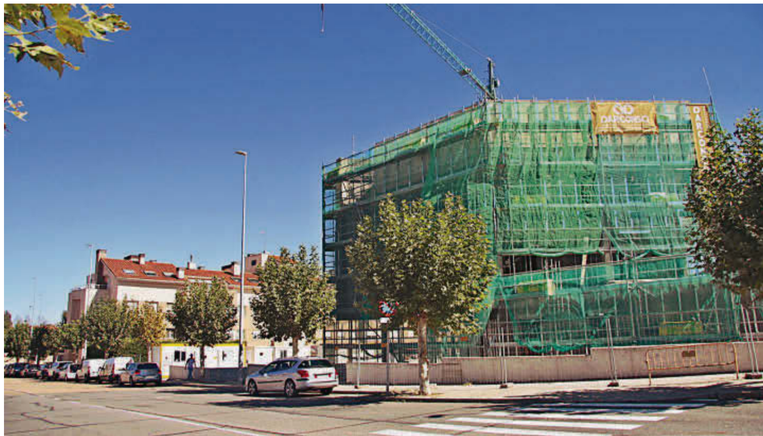
Estado actual de la obra del nuevo cuartel de la Guardia Civil en construcción en Santa Marta. FOTOS:EÑE
