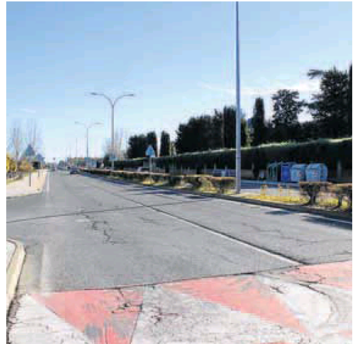
El tramo que será renovado en los próximos meses.
