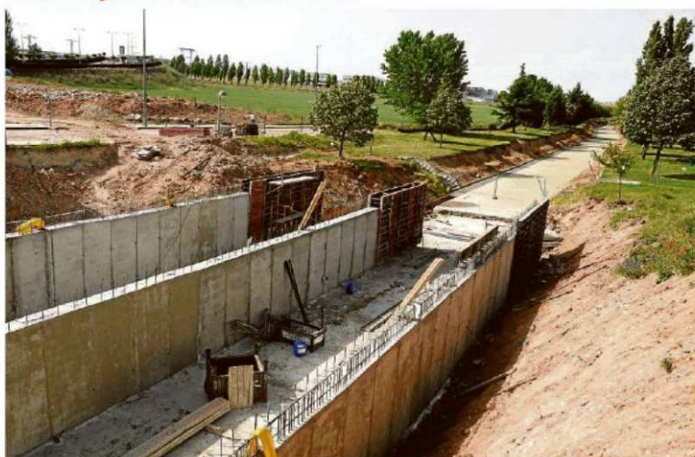
Las obras de la fase final de la cubierta del Arroyo de los Requesenes está junto al Camino de Carpihuelo. | ENE
