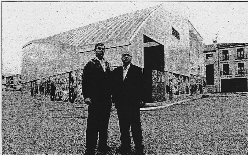
La cubierta del frontón está terminada a falta de instalar las puertas de acceso. En la foto, alcalde y teniente alcalde / PRIETO
