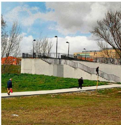
La pasarela peatonal la utilizan a diario muchos vecinos. | ENE
