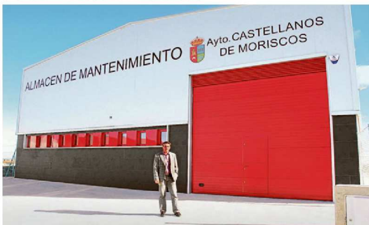
El alcalde ha recepcionado la obra, que ya acoge los vehículos y la maquinaria municipal de servicios. | ENE
