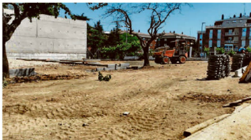
Inicio de las obras de la zona exterior del recinto del Área Joven Municipal de Santa Marta. | EFE
