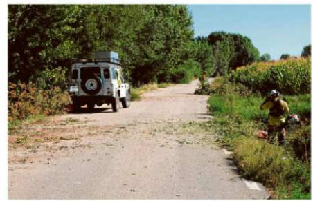
Los operarios procedieron a limpiar y despejar la calzada. | EÑE
