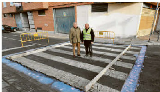
El edil de Tráfico en la obra de los nuevos badenes en Marcos Escribano. | EÑE
