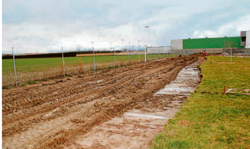
Las obras han comenzado con el desbroce y los movimientos de tierra en la zona de 'La Huerta'. | EÑE
