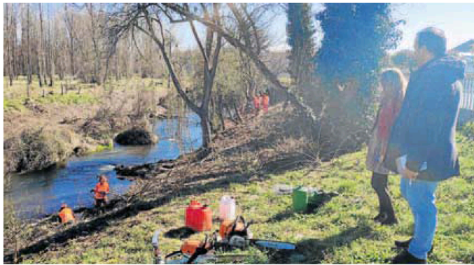
Trabajos de limpieza en la margen izquierda del río Tormes. WORD
