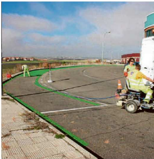
Operarios pintando el carril bici en la zona del polígono. | EÑE
