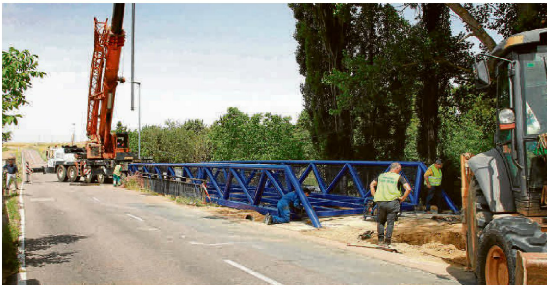
La instalación de la gran estructura sobre el arroyo obligó a cortar el acceso a Cabrerizos durante toda la mañana. | ENE
