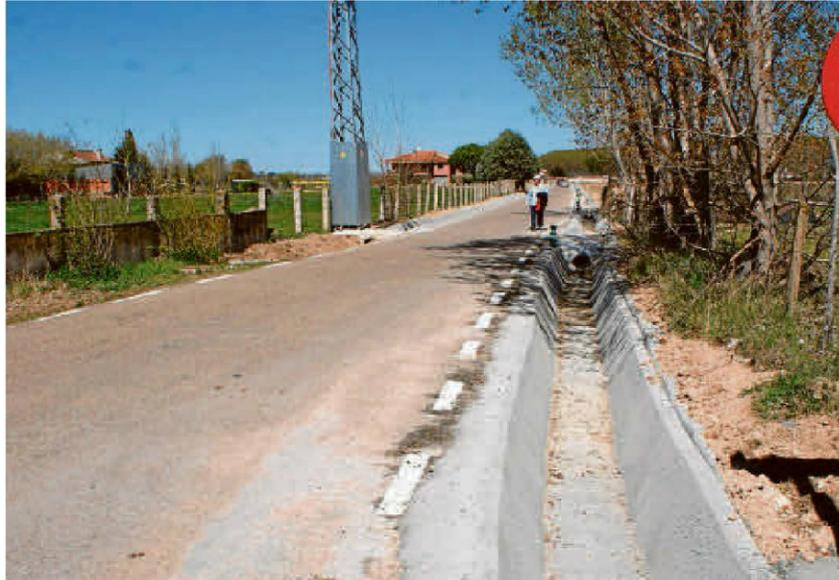
Las cunetas se han canalizado con una estructura de cemento aprovechando el ancho existente. | ENE
