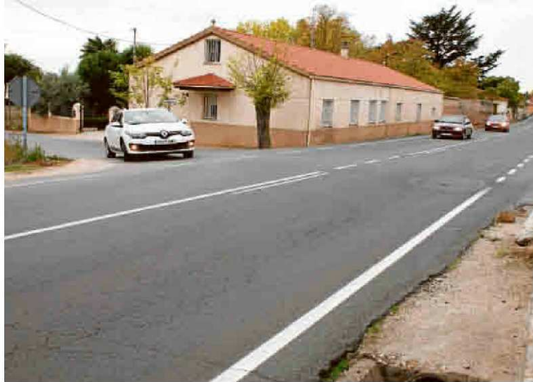
El cruce de la SA-804 hacia la urbanización Las Dunas contará con semáforos para garantizar la seguridad. | EÑE
