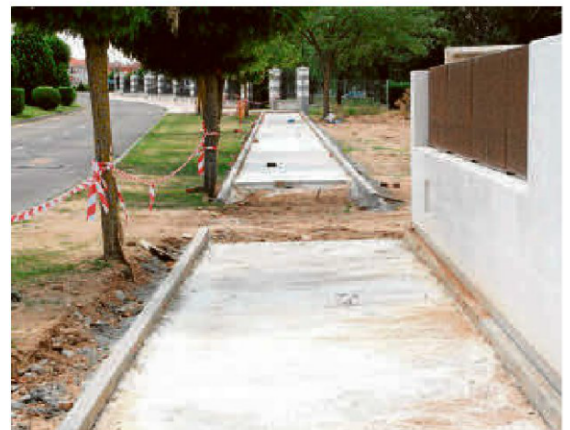
Obras del nuevo acerado peatonal en el Camino de Carpihuelo. | ENE
