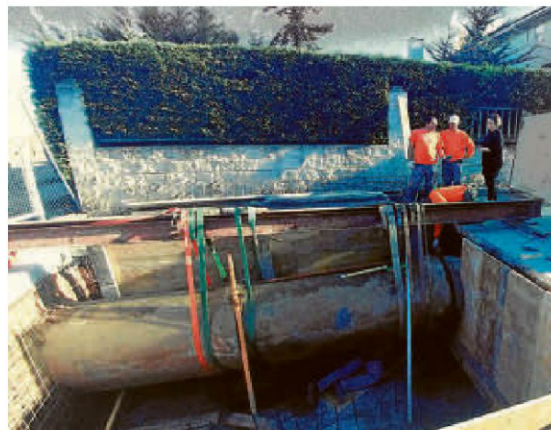
Obras en el aliviadero de la calle Soto en Villas de Valdelagua. | ENE
