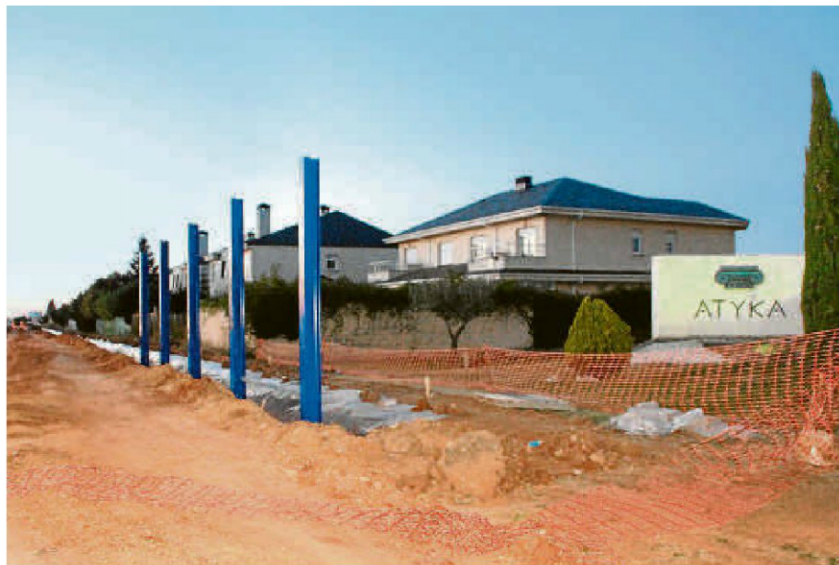
La empresa ha delimitado la zona y ya están los pivotes donde irá instalada la pantalla acústica. | ENE
