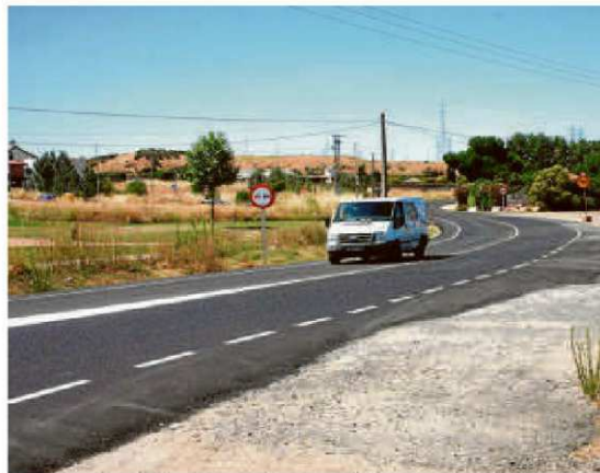
La carretera ya está abierta al tráfico y con la nueva señalización. | ENE
