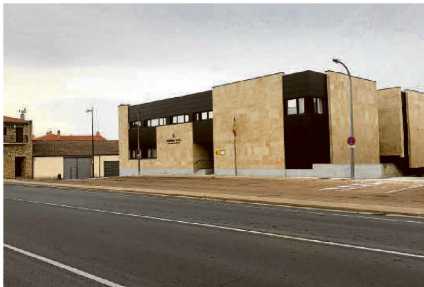
El cuartel de la Guardia Civil de Villares comparte instalaciones con el edificio consistorial junto a la travesía. | ENE
