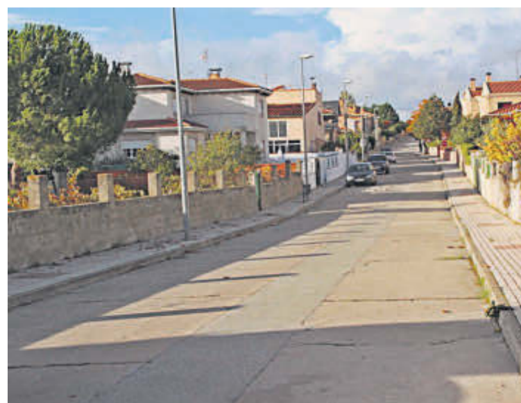
La calle Miguel de Unamuno contará con red separativa de aguas. | EÑE
