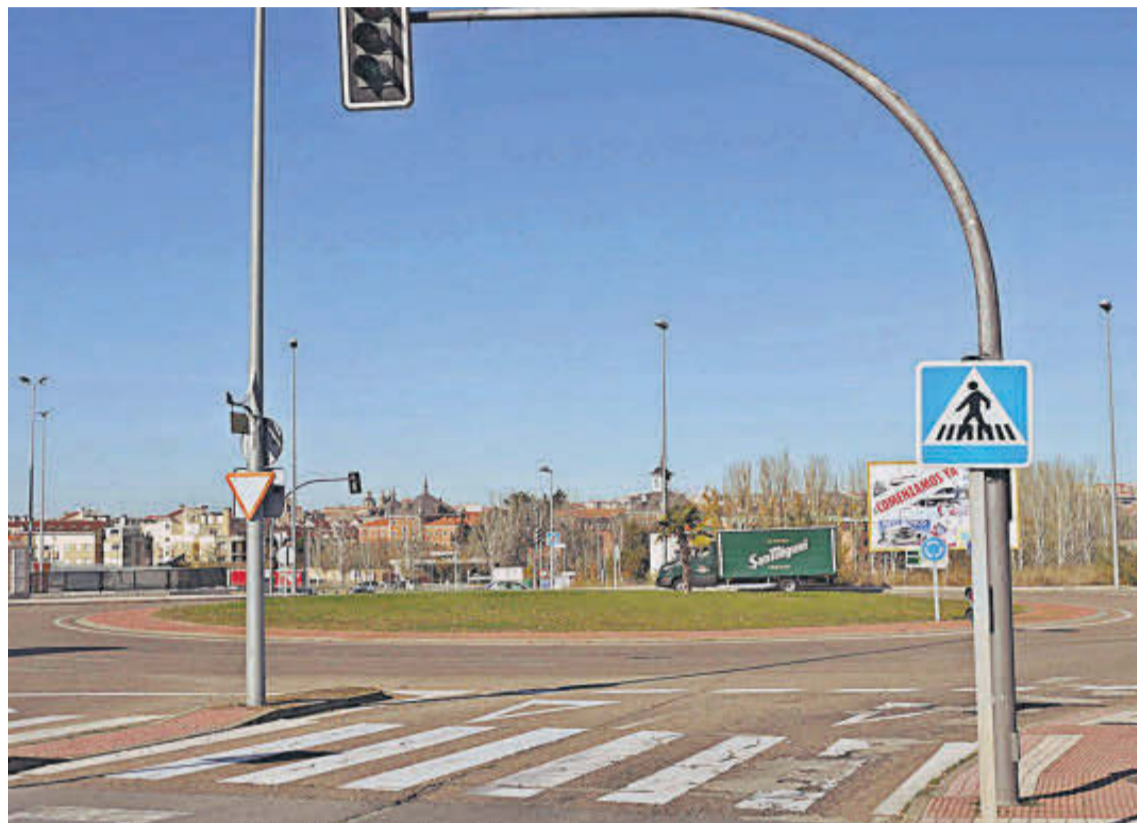
Una de las tres rotondas en las que mañana comenzarán los trabajos de asfaltado. | EÑE
