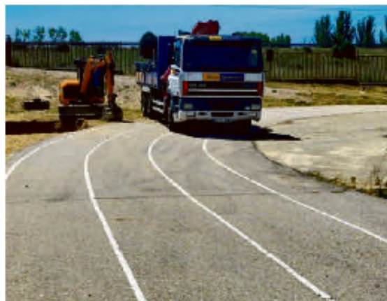
Inicio de las obras de la pista ubicada en el colegio Miguel Hernández. | ENE
