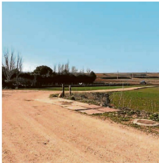
Camino Alto de Villamayor por el que discurrirá el nuevo colector. | EÑE
