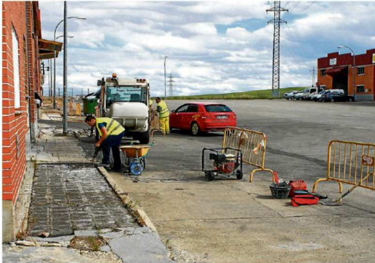
Los seis operarios han iniciado las obras de arreglo y renovación de los viales del polígono industrial. | EÑE
