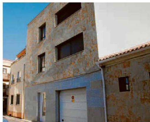
El edificio de la calle Oro que albergará dependencias municipales. | EÑE
