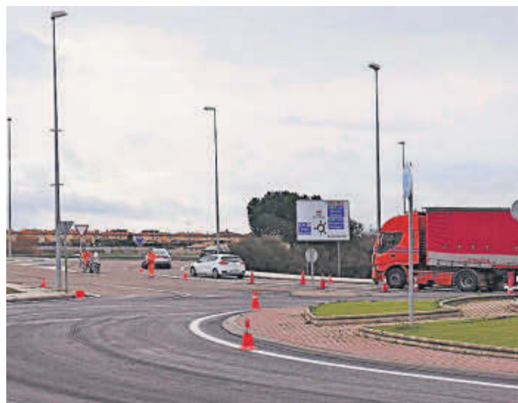
Los trabajos de señalización en las rotondas de Carbajosa. | EÑE
