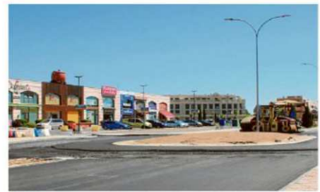
El tráfico estuvo cortado por la pavimentación de la avenida. | ENE
