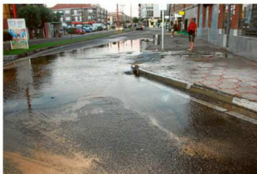
La zona se llenó de agua debido a la avería.
