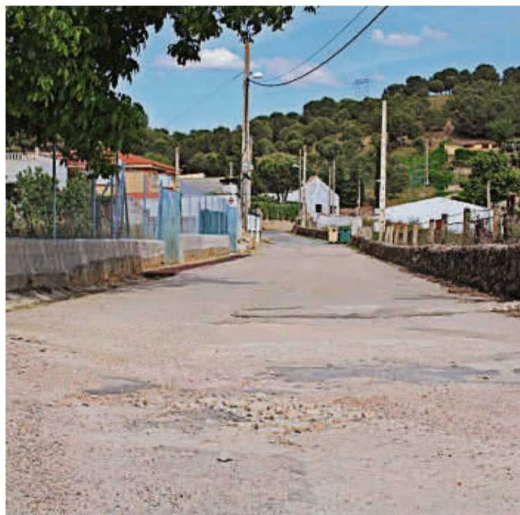
El camino de El Pinar se encuentra deteriorado. | EÑE
