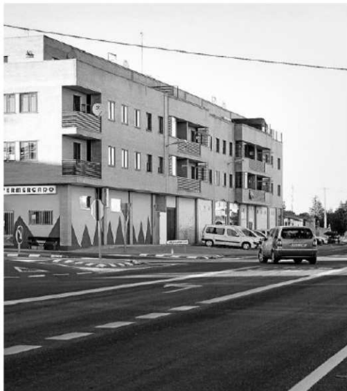
La localidad sólo cuenta con un punto de acceso desde la N-630. | ENE
