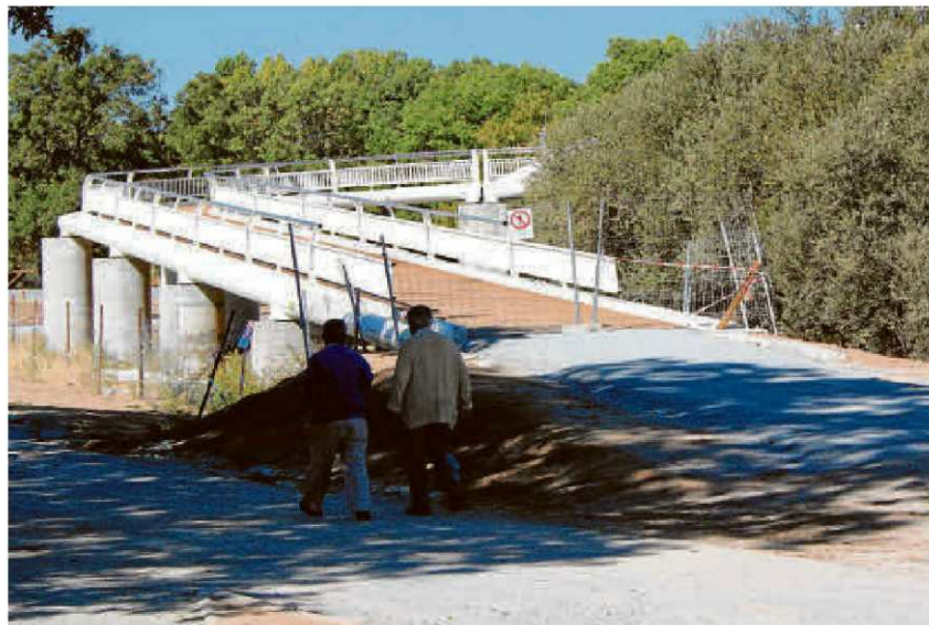
La estructura de la pasarela ya está instalada y con la barandilla colocada en las rampas de acceso. | EÑE
