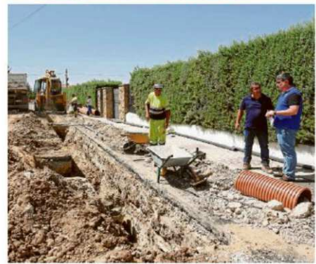
El concejal de Obras Públicas, Ángel Manso, visitó las obras. | EÑE
