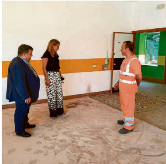
Los ediles Francisco Miguel García y Marta Labrador visitaron las obras. | ENE
