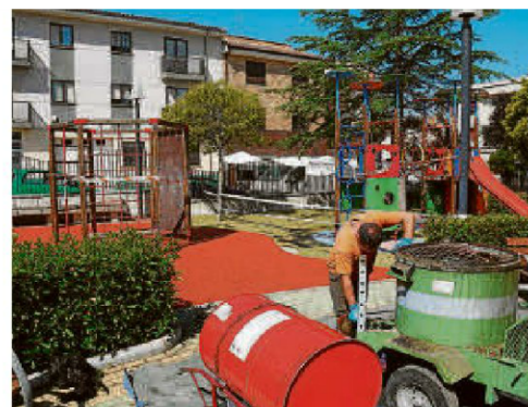
Obras de sustitución del suelo de caucho de 'La Charca'. | EÑE
