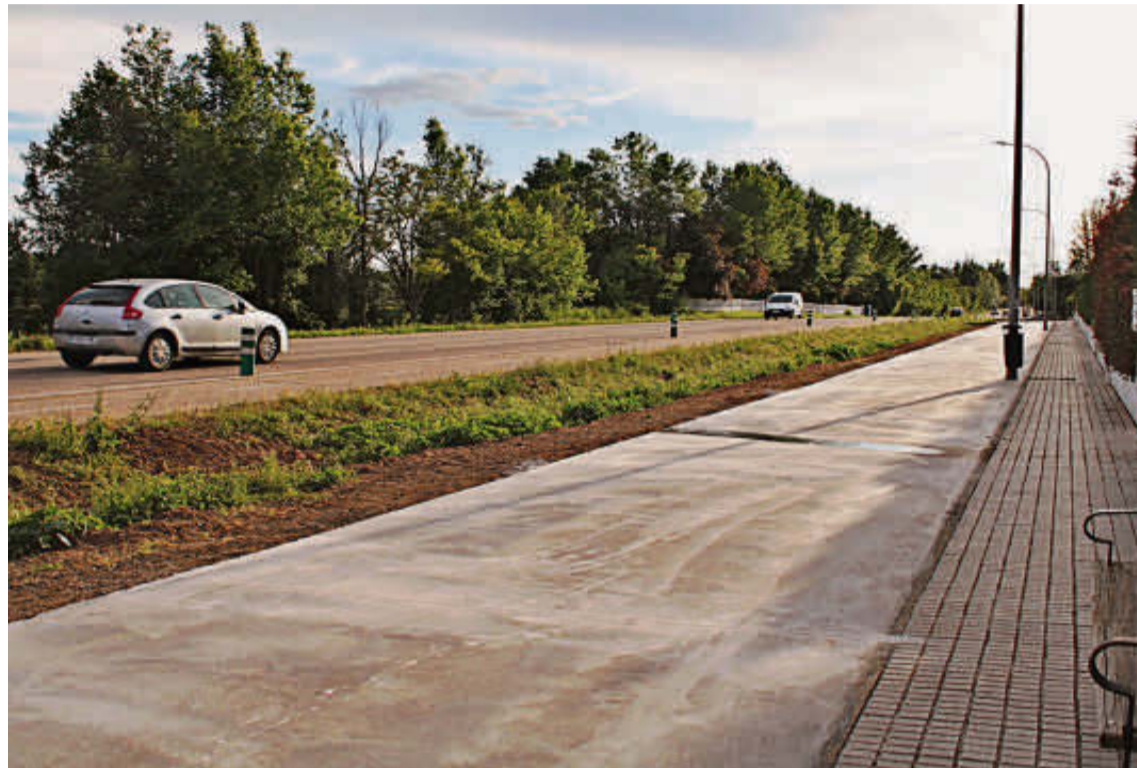
Primer tramo del nuevo acerado en la urbanización Almendares de Santa Marta. | EÑE
