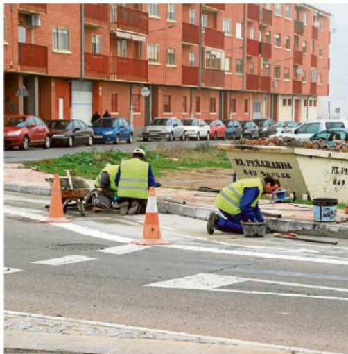
Últimas obras de rebaje de bordillos en la carretera de Madrid. | ENE
